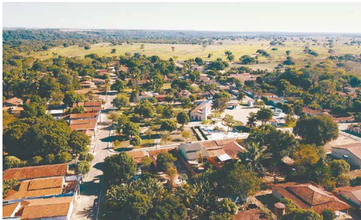
Com mais de R$ 3 milhões aplicados, as obras estão distribuídas em diversos bairros de Bom Jesus
